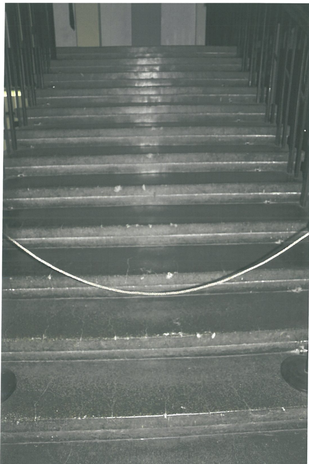
Fot.21. Dom Legionisty im. Marszałka Józefa Piłsudskiego w Krakowie, ul. 3 Maja 7/ Oleandry 2. Wnętrze , fragment klatki schodowej, stopnie z lastryka . Widoczne uszkodzenia krawędzi.
