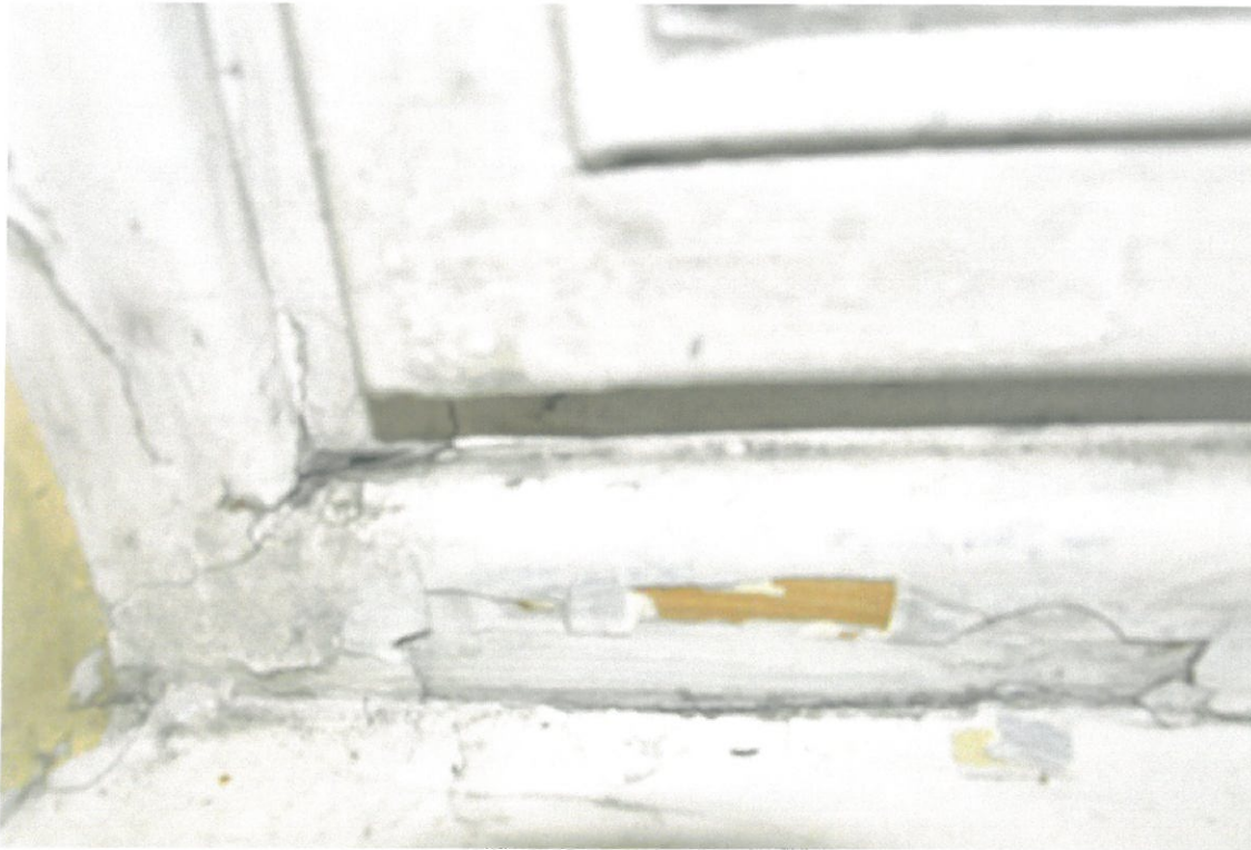
Fot.25. Dom Legionisty im. Marszałka Józefa Piłsudskiego w Krakowie, ul. 3 Maja 7/ Oleandry 2. Wnętrze. Fragment zachowanej oryginalnej stolarki okna. Widoczne łuszczące się nawarstwienia powłok lakierniczych.
