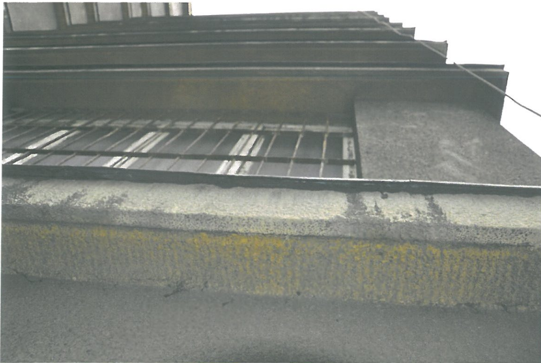
Fot.5, 6. Dom Legionisty im. Marszałka Józefa Piłsudskiego w Krakowie, ul. 3 Maja 7/ Oleandry 2. Fragmenty elewacji, pod nawarstwieniami widoczna ryflowana forma pierwotnego tynku.
