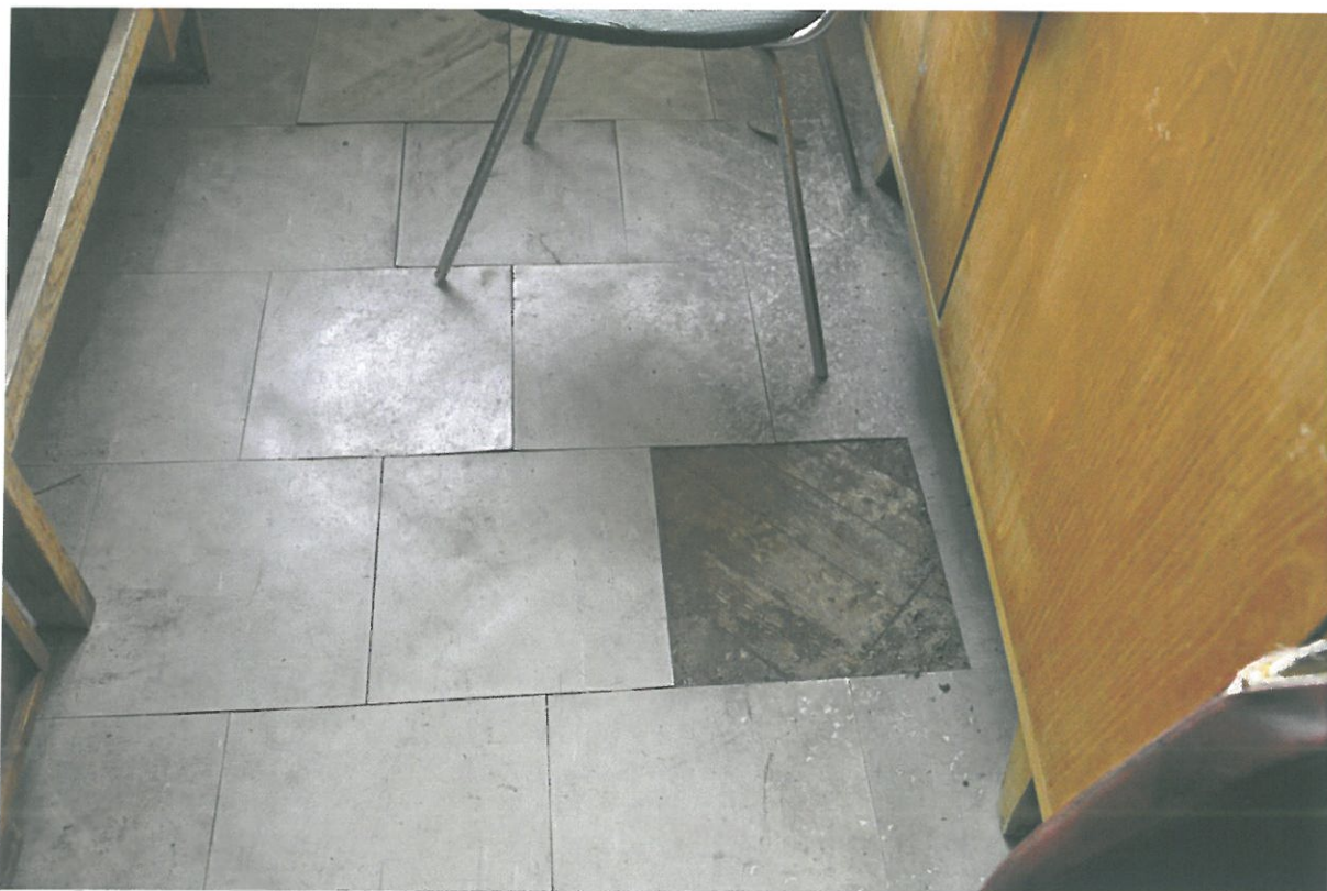
Fot.17. Dom Legionisty im. Marszałka Józefa Piłsudskiego w Krakowie, ul. 3 Maja 7/ Oleandry 2. Wnętrze, fragment podłogi z parkietem przykrytym płytkami PCV.
