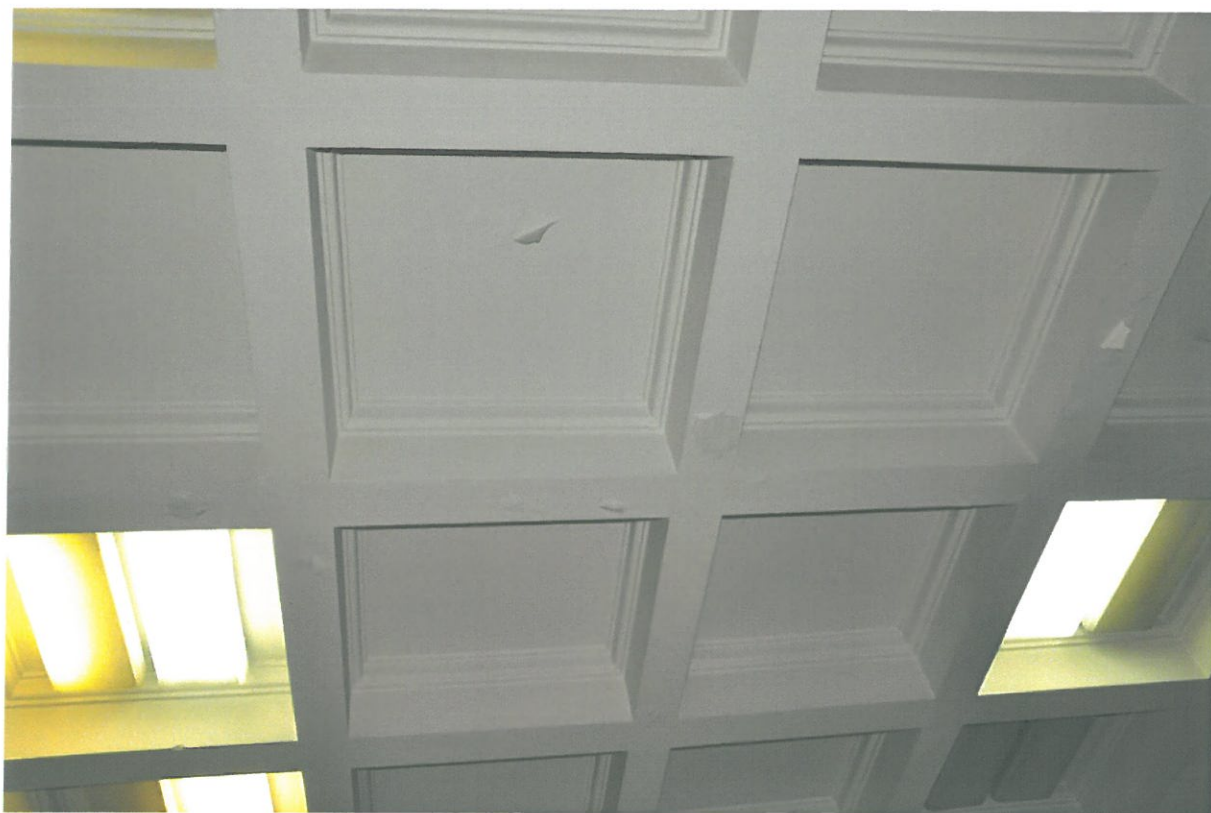
Fot.10, 11. Dom Legionisty im. Marszałka Józefa Piłsudskiego w Krakowie, ul. 3 Maja 7/ Oleandry 2. Wnętrze, fragmenty pseudo kasetonowego stropu w holu głównym. Widoczne łuszczące się powłoki malarskie.
