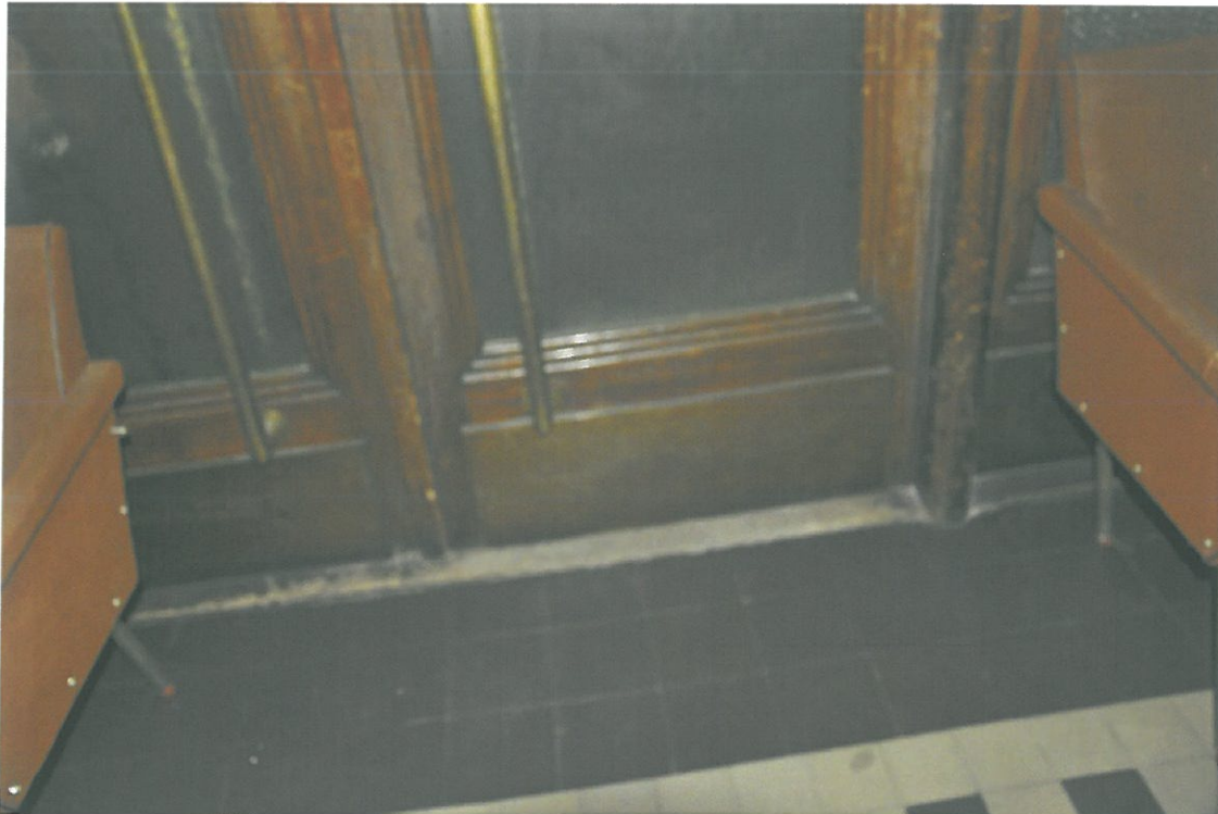
Fot.26. Dom Legionisty im. Marszałka Józefa Piłsudskiego w Krakowie, ul. 3 Maja 7/ Oleandry 2. Wnętrze. Fragment zachowanej oryginalnej stolarki drzwi na klatce schodowej. Widoczne poprzecierane powłoki lakiernicze i zaśniedziałe okucia mosiężne.
