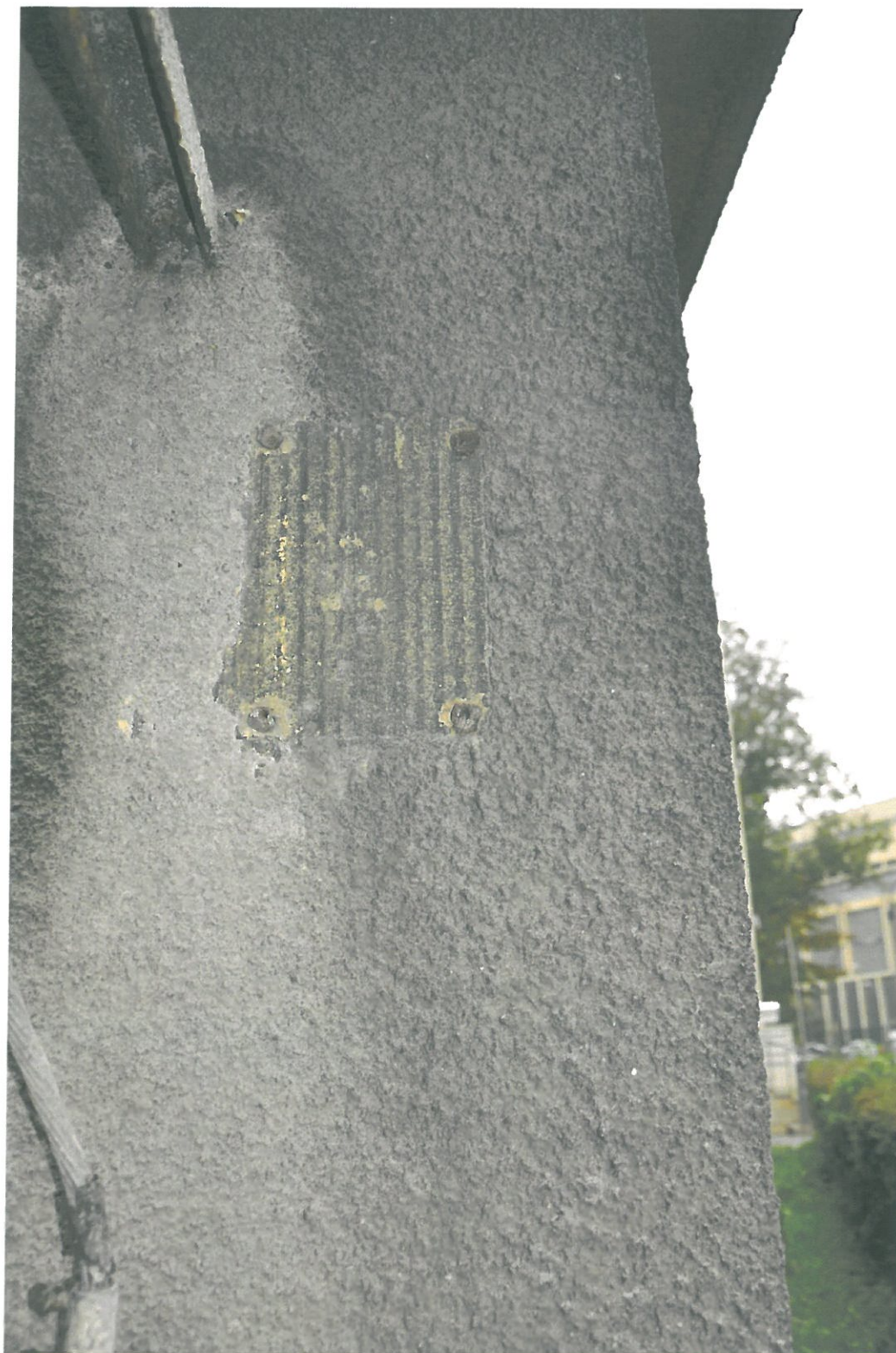
Fot.7. Dom Legionisty im. Marszałka Józefa Piłsudskiego w Krakowie, ul. 3 Maja 7/ Oleandry 2. Fragment elewacji, pod nawarstwieniami widoczna ryflowana forma pierwotnego tynku.
