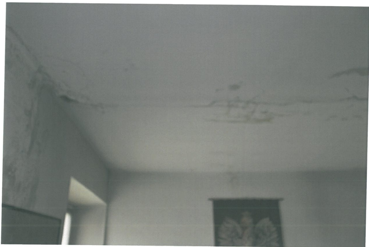
Fot.28. Dom Legionisty im. Marszałka Józefa Piłsudskiego w Krakowie, ul. 3 Maja 7/ Oleandry 2. Wnętrze. Fragment sufitu klatki schodowej na najwyższej kondygnacji, widoczne plamy powstałe skutkiem zalania zalaniem .
